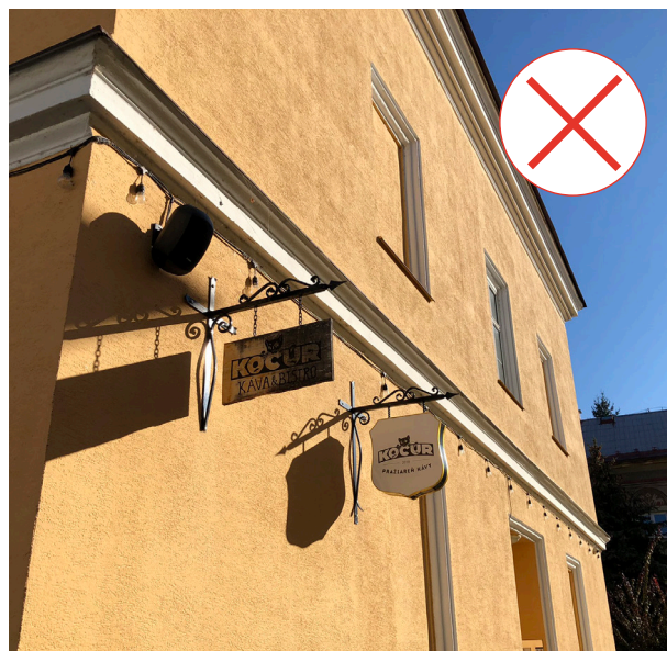
49 - Nevhodný príklad umiestnenia viacerých štítov jednou prevádzkou.
