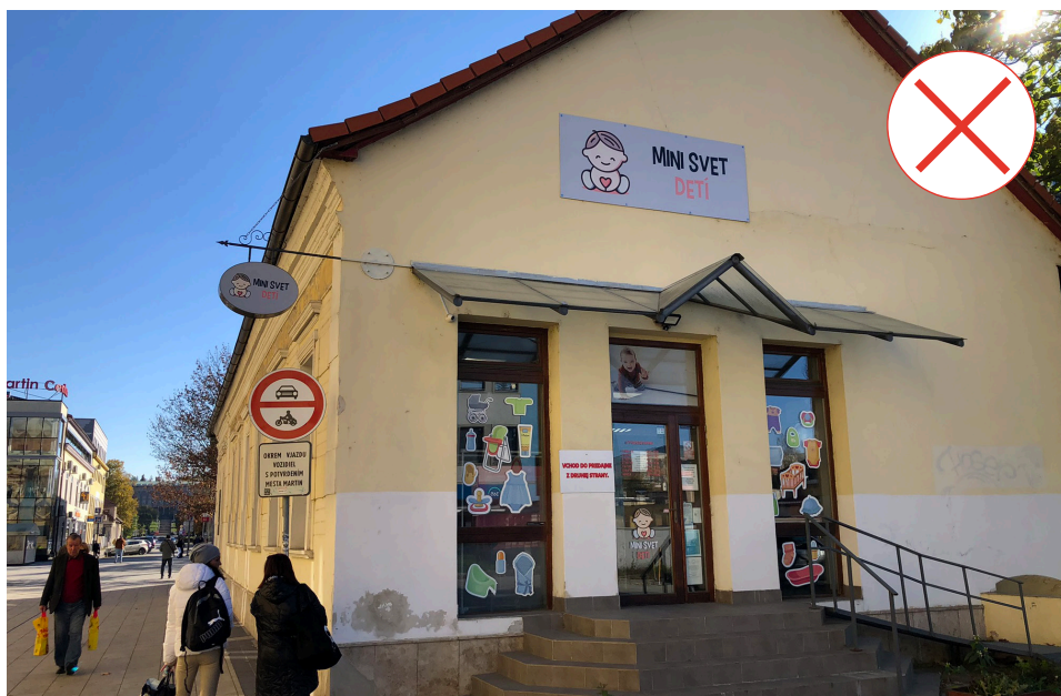
03 - Nevhodný príklad umiestnenia označenia prevádzky nad úrovňou korunnej rímsy.
