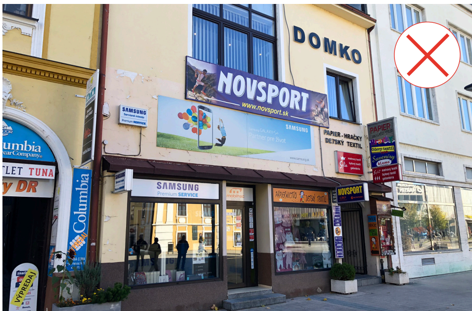
24 - Nevhodný príklad umiestnenia reklamných stavieb a zariadení nad úrovňou 1.NP, viditeľné vedenie kabeľáže, umiestňovanie viacerých štítov a označení prevádzok.
