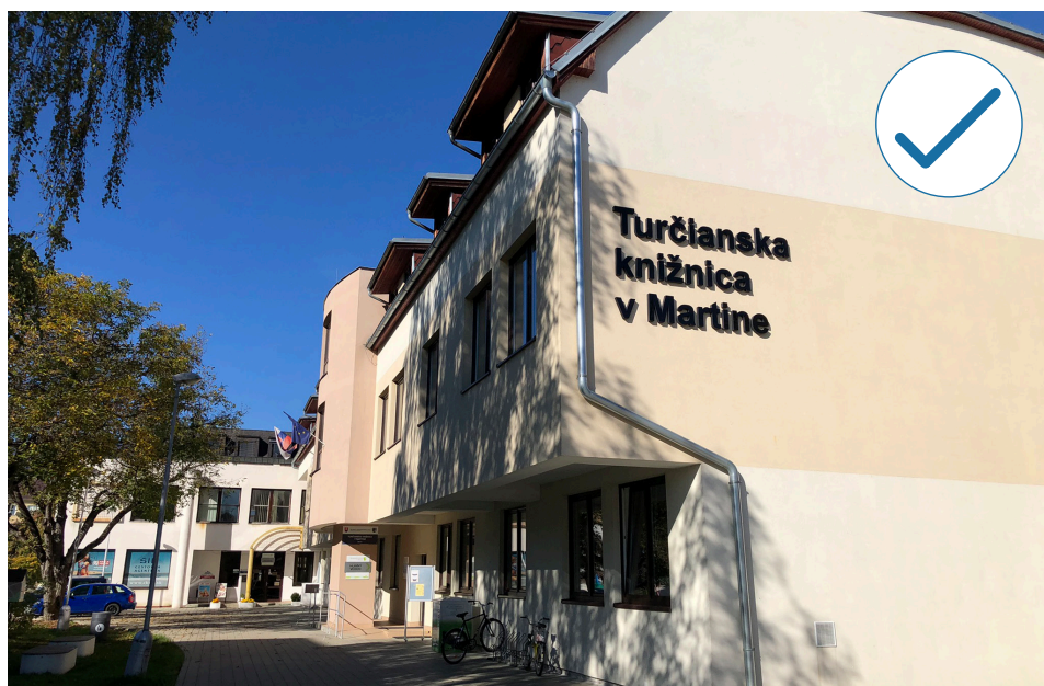
38 - Dobrý príklad umiestnenia a dizajnu označenia významnej prevádzky zo samostatných písmen umiestneného na fasáde objektu.
