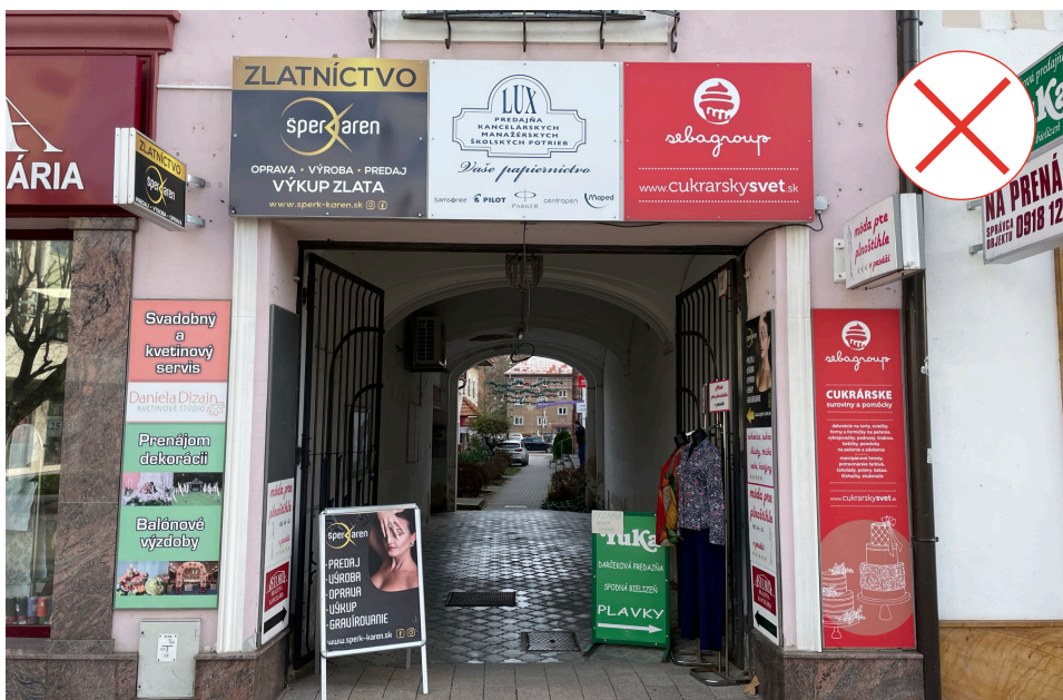
26 - Nevhodná forma a dizajn označenia viacerých prevádzok nachádzajúcich sa v pasáži, ako i nevhodné umiestnenie štítov a reklamných áčiek.
