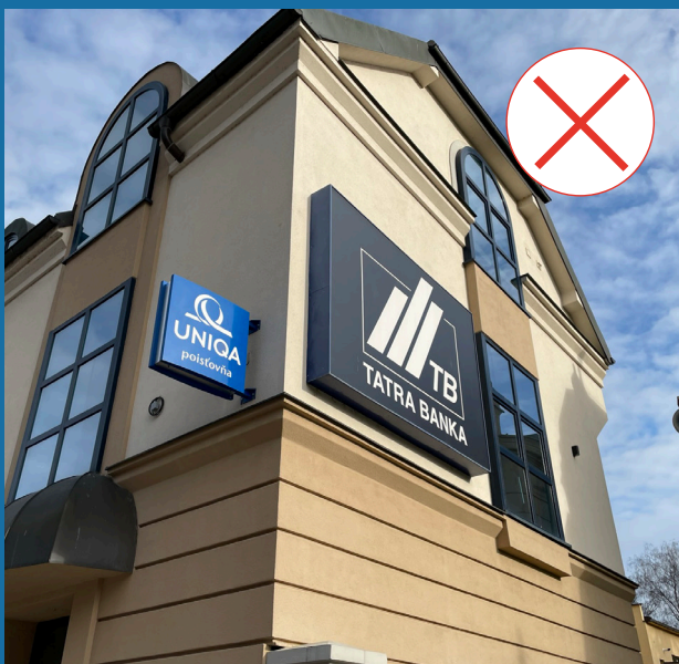
66 - Nevhodný príklad umiestnenia veľkoplošnej reklamnej stavby na fasáde budovy.
