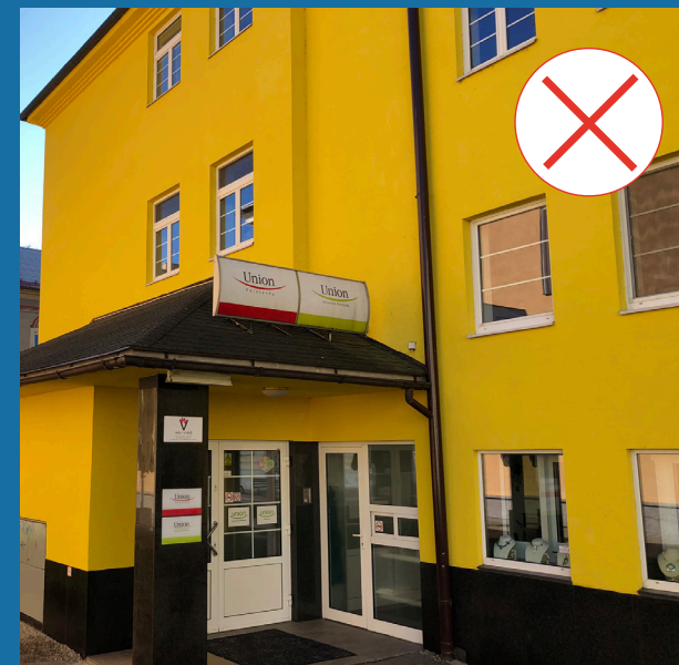
68 - Nevhodný príklad umiestnenia hlavného označenia prevádzky na streche budovy.
