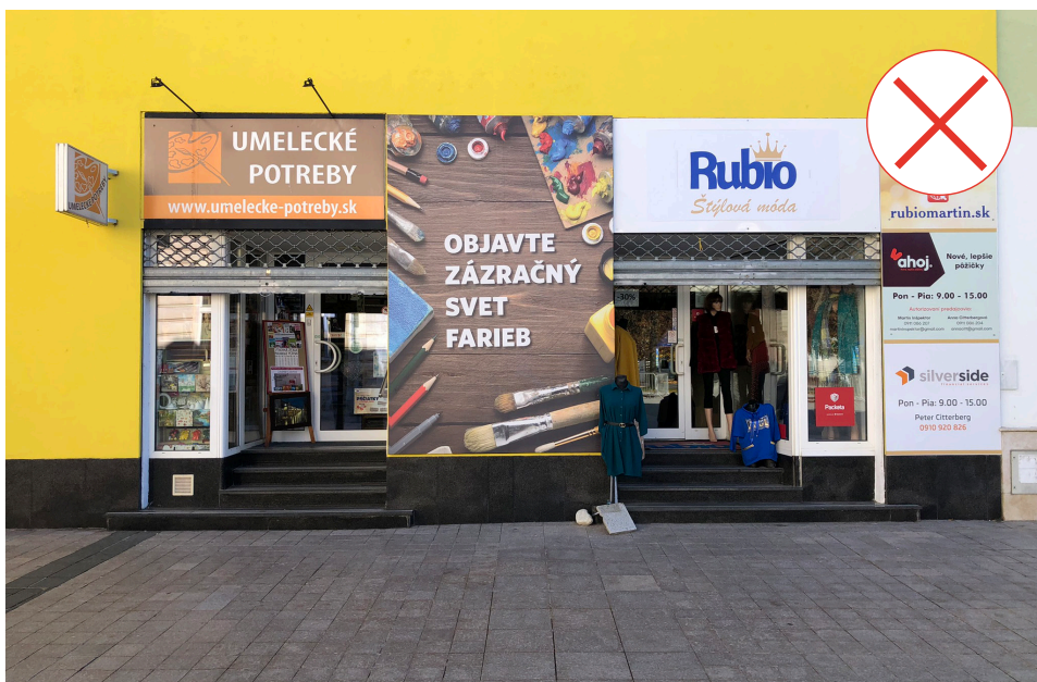
18 - Nevhodný príklad veľkoplošného označenia prevádzky, jeho viditeľného osvetlenia a umiestnenia predávaného tovaru pred predajňu do verejného priestoru, či prekrytia fasády objektu reklamnými stavbami a zariadeniami
