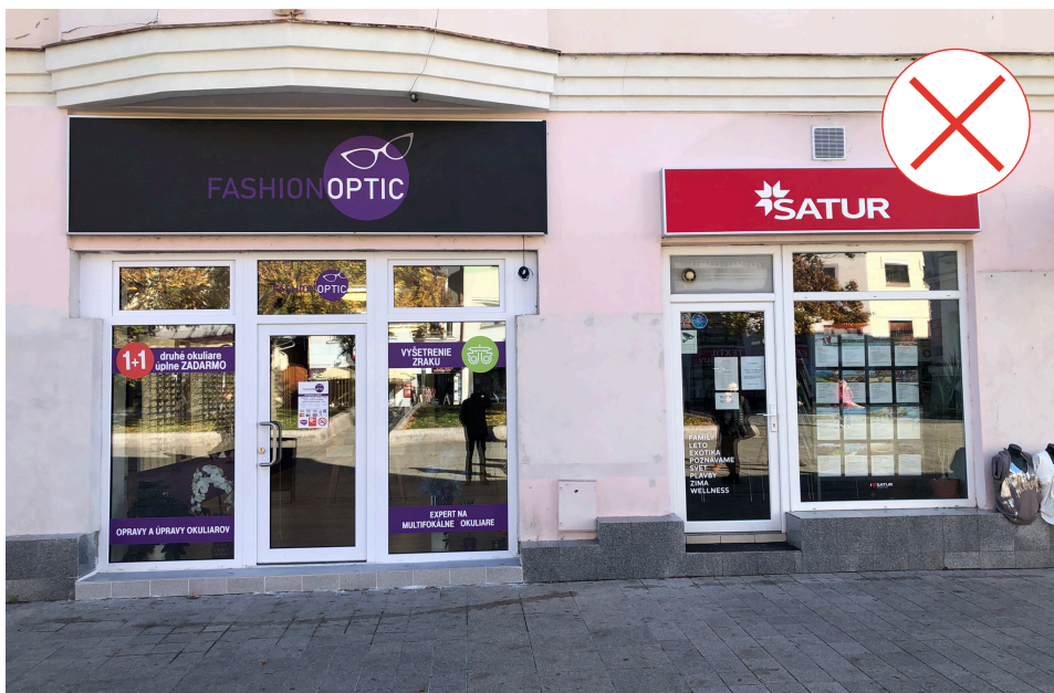
17 - Nevhodný príklad rozdielnych veľkostí a dizajnu prevádzok umiestnených v rámci jednej budovy.
