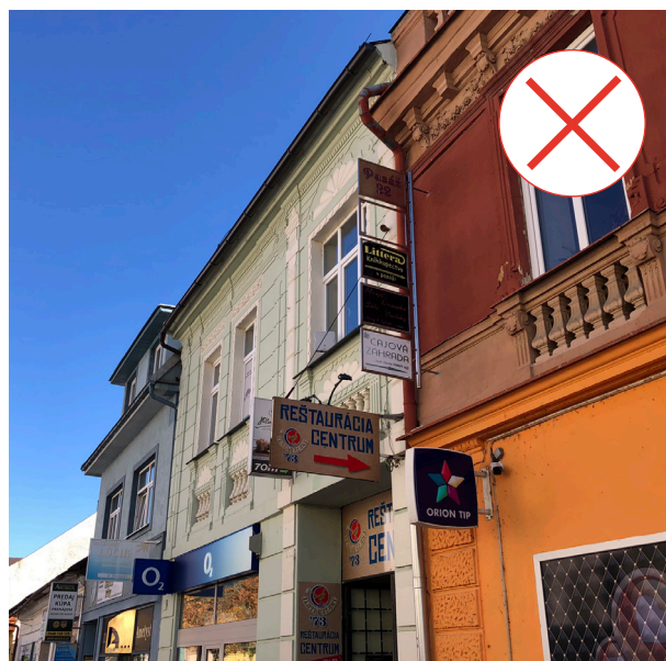
51 - Nevhodný príklad dizajnu a umiestňovania viacerých štítov prevádzok v pasáži na fasáde objektu a nad úrovňou 1. NP.
