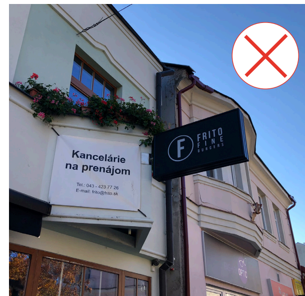
50 - Nevhodný príklad umiestnenia štítu nad úroveň 1. NP.
