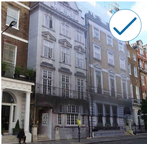
75 - Dobrý príklad interpretácie rekonštruovanej fasády vytlačenej na ochrannom pletive lešenia.
