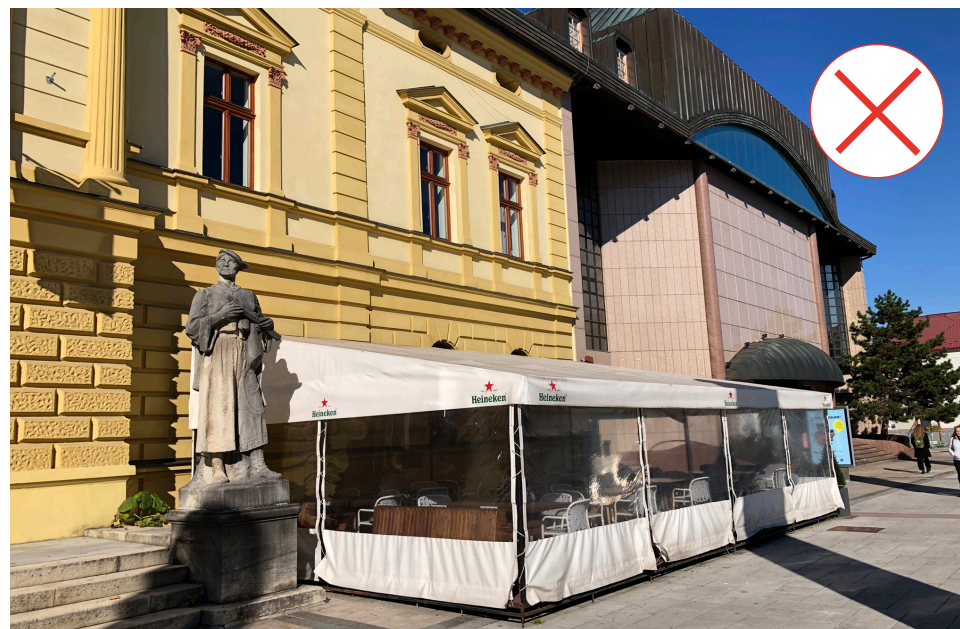
33 - Nevhodné prekrytie terasy, ktoré prekrýva architektúru objektu významnej prevádzky.
