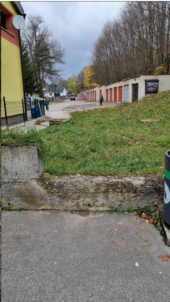
POHĽAD NA BETÓNOVÝ MŮRIK PRI NÁSTUPNEJ PLOŠINE.
