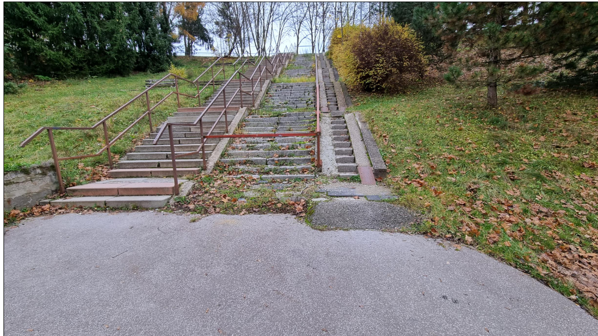
CELKOVÝ POHĽAD NA SCHODISKO Z JAHODNÍKOV.
