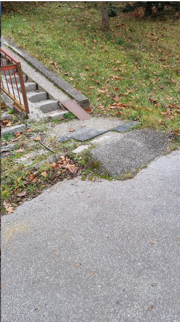
NÁBEH NA SCHODISKO S RAMPOU.
