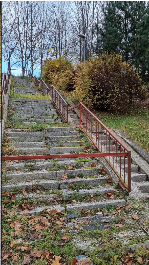
STREDOVÁ NEVYUŽÍVANÁ ČASŤ SCHODISKA.
