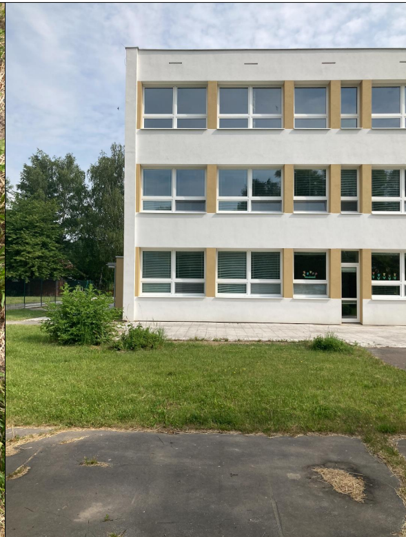
POHĽAD NA TERASU PRI BUDOVE JASLÍ.
