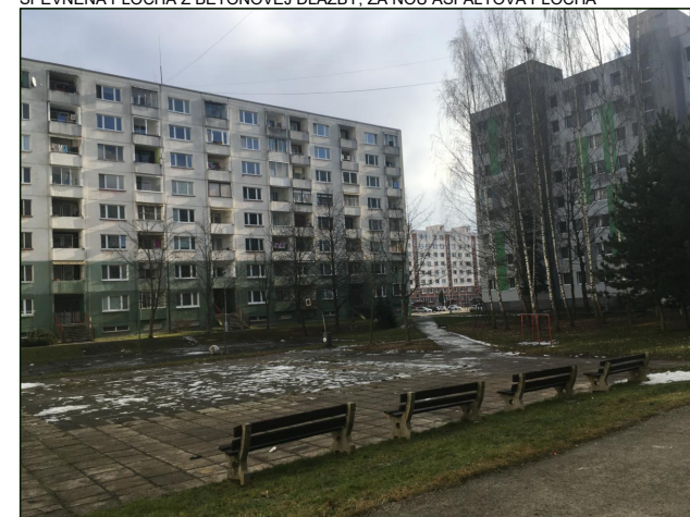
SPEVNENÁ PLOCHA Z BETÓNOVEJ DLAŽBY, ZA ŇOU ASFALTOVÁ PLOCHA
