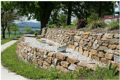
příklad riešenia suchého múrika z prírodného kameňa
