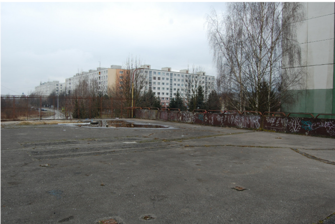
Nefunkčné odvodnenie priestoru
