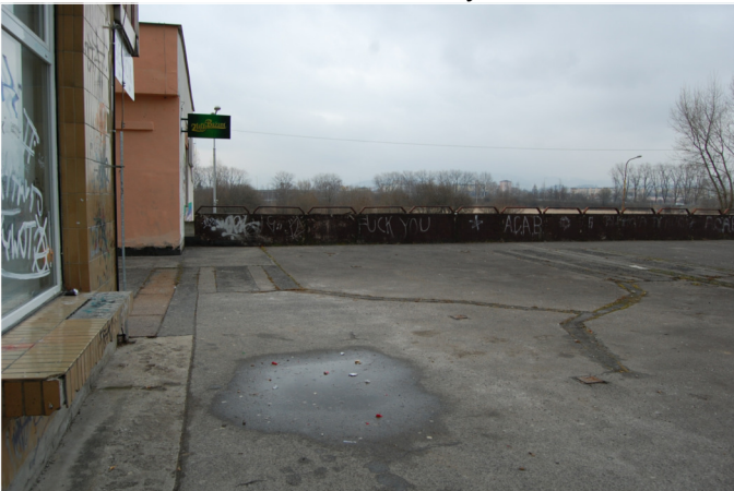
Nefunkčné odvodnenie priestoru
