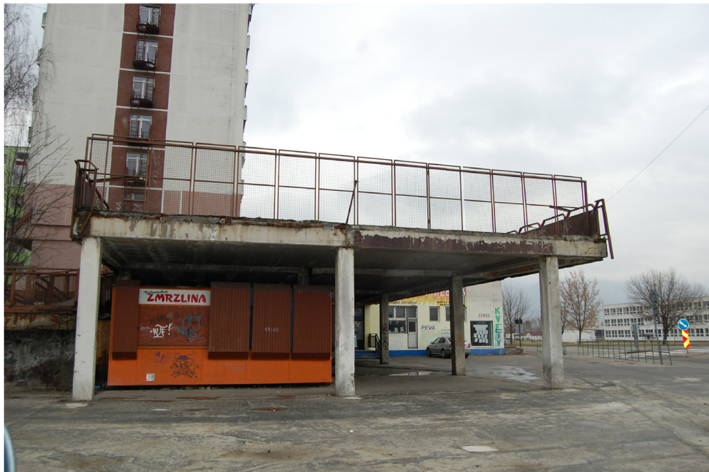
Súčasný technický stav
