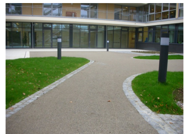
Obr.6 Mlatový chodník s kamenným obrubníkom
